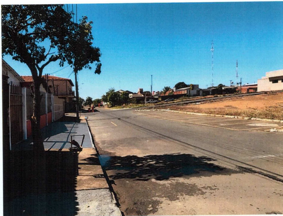
Vista do Imóvel
